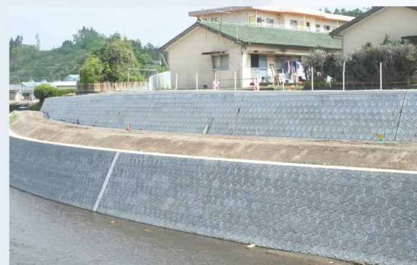
■ 山田川護岸工事
