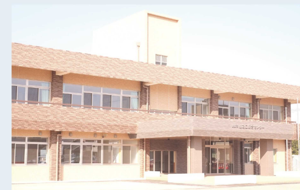
■ 都城市山之口総合支所
