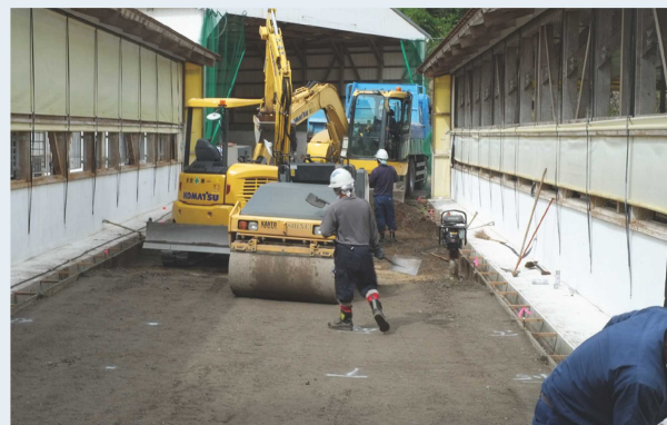
■ JA みやざき農場内舗装
